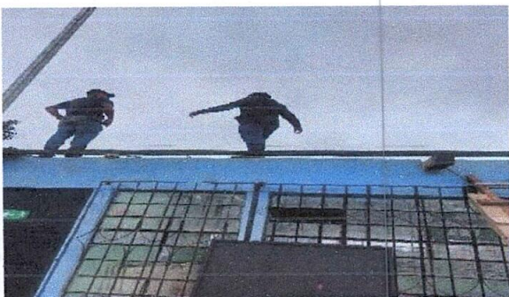
Foto 3: Sustitución de Puerta
