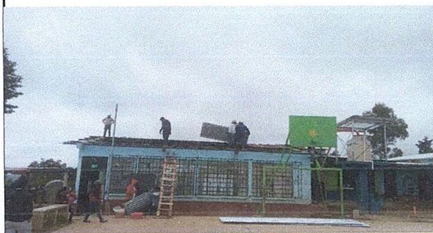
Foto 4: Sustitución de Techo Aluzinc
