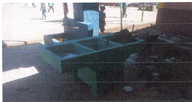
Foto 6: Sustitución de Pila
